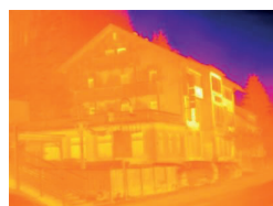
Épület hőképe testo SkálaAsszisztens nélkül
